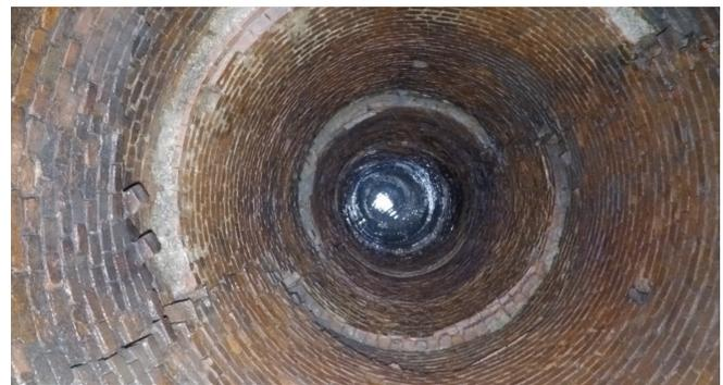
Vor der Sanierung des auffallend rissigen, 40m tiefen Schachts mussten mehrere Leitbleche entfernt werden.
