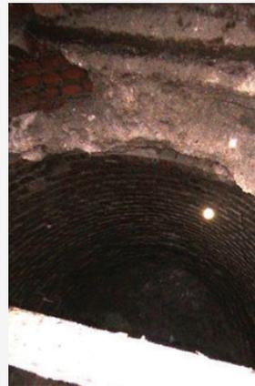
*15 Betonabweiser, wie dieser gezeigte beschädigte, mussten vollständig aus dem Schacht entfernt werden.*
