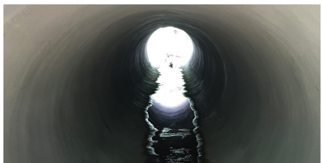
QLS GeoKrete wurde aufgespritzt und anschließend gespachtelt, um eine glatte, gleichmäßige Dicke zu erreichen.
