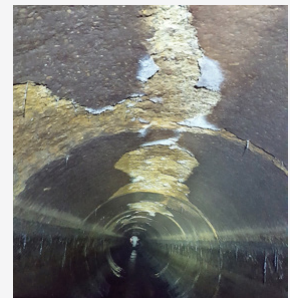
Eine veraltete Kanalisationsinfrastruktur in Verbindung mit starker Korrosion und den negativen Auswirkungen des Hurrikans Sandy führte zu einer umfassenden Sanierung und strukturellen Wiederherstellung.
