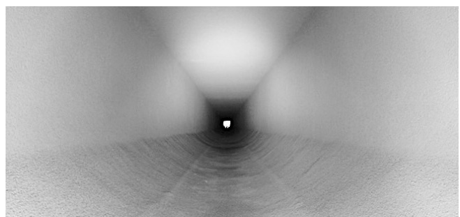
Kastendurchlass nach GeoKrete Geopolymer Auskleidung.
