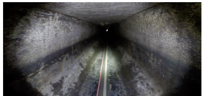
Kastendurchlass für die Auskleidung vorbereitet.
